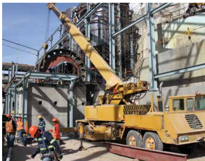
Instalación del nuevo molino balero en El Cubo
